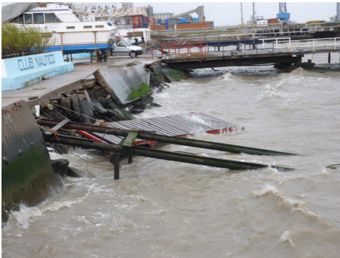
Una planchada flotante que se desprendió y fue a parar contra la escollera
