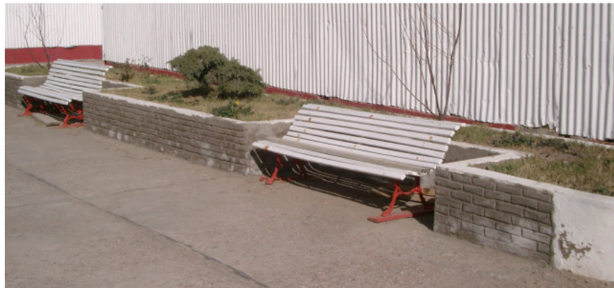
Reparación de canteros y colocación de plantas de tamarisco
