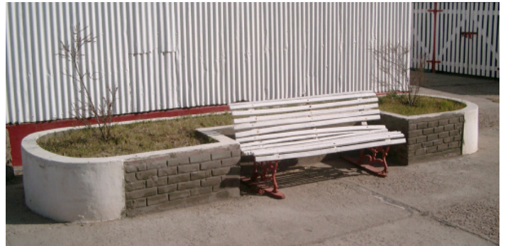
Reparación de canteros y plantación de tamariscos
