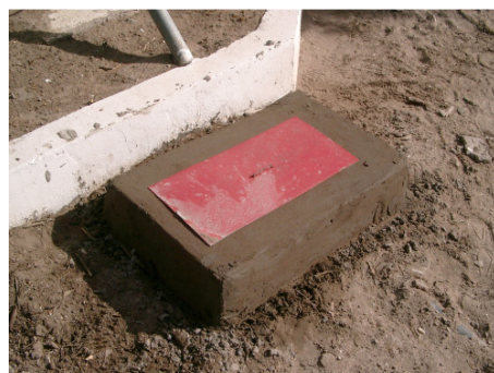
Reparación cámara bomba de agua p/piletas
