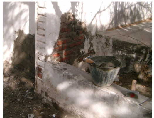
Reparación revoques depósito sector quinchos
